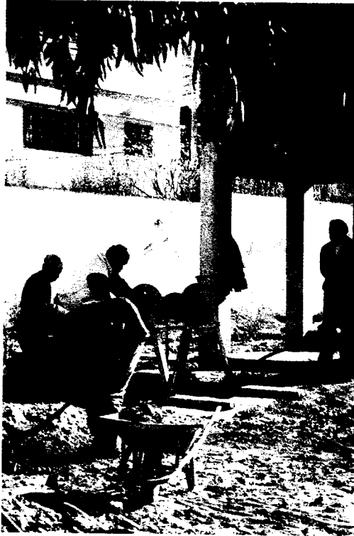
Photo 3. Travaux de construction du puits et du réservoir d'eau au sein de l'école Oued El Makhazine
