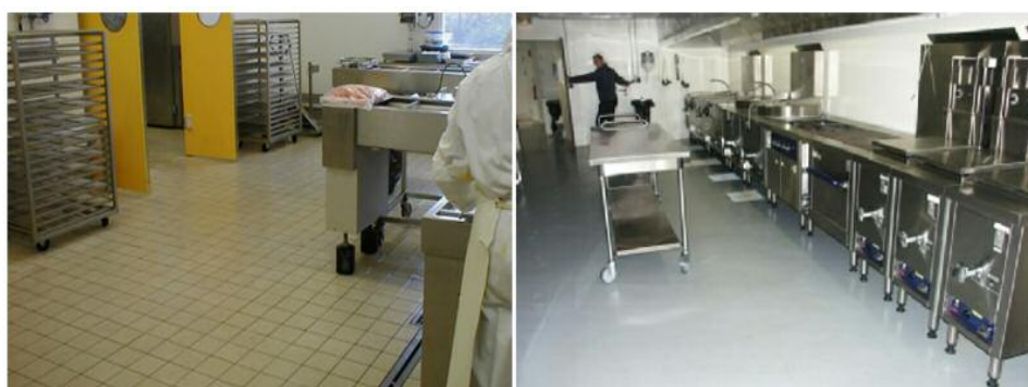
Figure 3: Types de revêtement pour sol, à gauche: carrelage en grès cérame antidérapant; à droite: résine époxy
