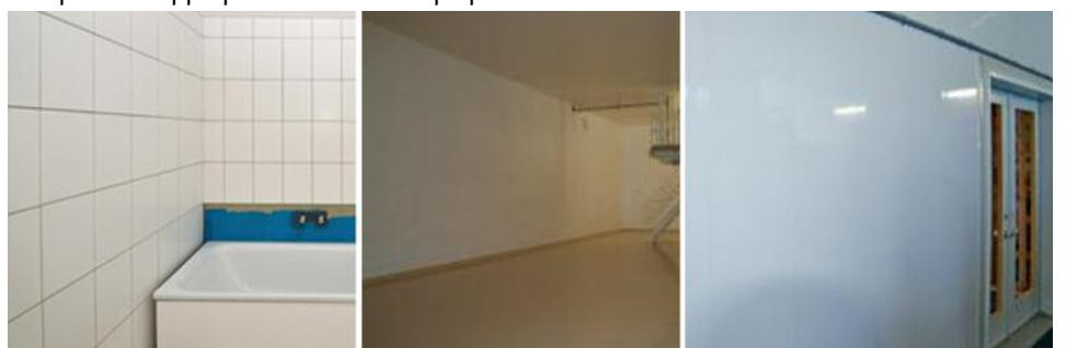
Figure 4: Exemples de revêtements pour murs. De gauche à droite: carrelage en grès céramique, peintures lavables sur support lisse et panneaux muraux en PVC
