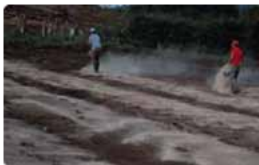
Photo 5 : Application manuelle de la chaux .
